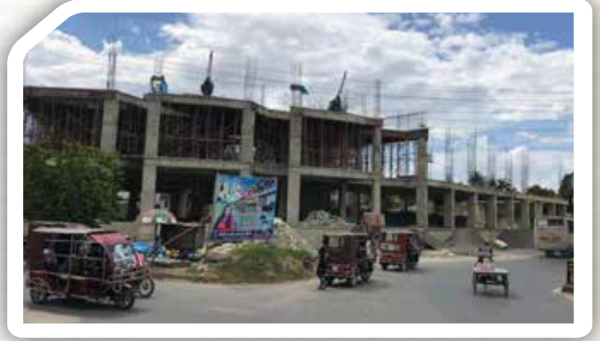
বঙ্গবন্ধু স্কয়ার ভবন নির্মাণের স্থির চিত্র
