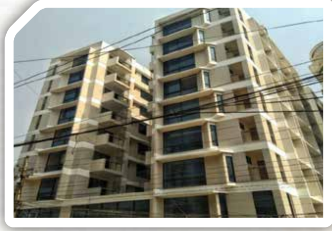
সকল নির্মাণ কাজ সম্পন্ন হয়েছে সমগ্র অগ্রগতি-১০০%
