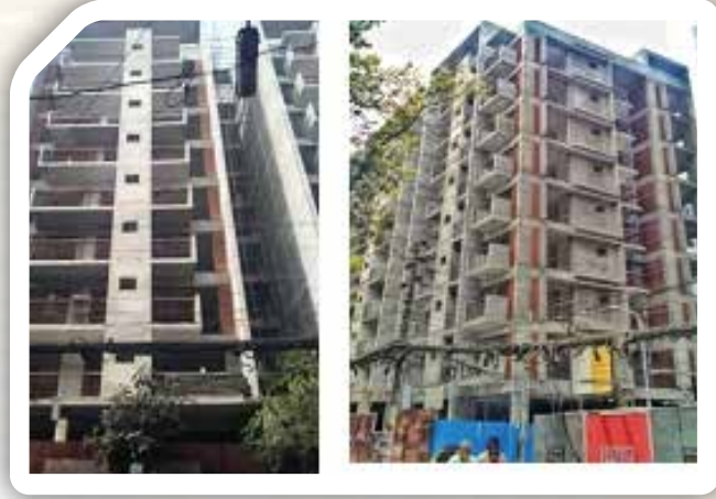
সকল তলার ছাদ ঢালাই, ব্রিকওয়াল, প্লাস্টার, রং, চৌকাঠ ও গ্রীল স্থাপন স্যানিটারি কাজ সম্পন্ন হয়েছে। বাউণ্ডারিওয়াল-এর কাজ চলমান রয়েছে। সমগ্র অগ্রগতি-৯০%
